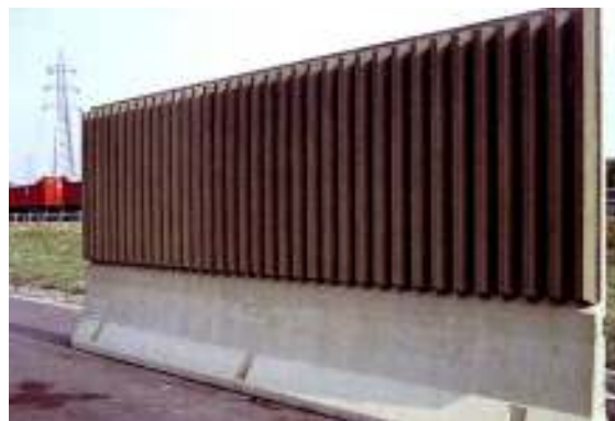
Figura 77 Barreira com processo de isolamento e absorção conjugados – Estrutura em concreto compacto, faceada com tiras de concreto granular, em Milão, Itália.
