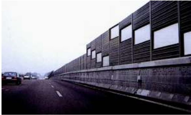
Figura 81 Barreira metálica combinada com painéis transparentes.
