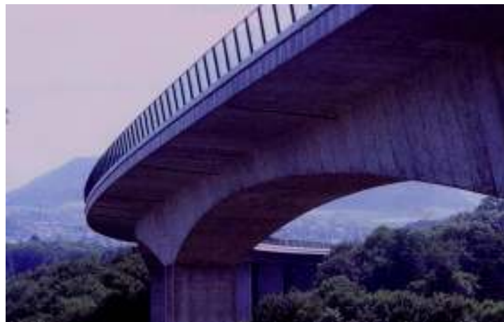
Figura 85 Barreira em vidro sobre viaduto de concreto.
