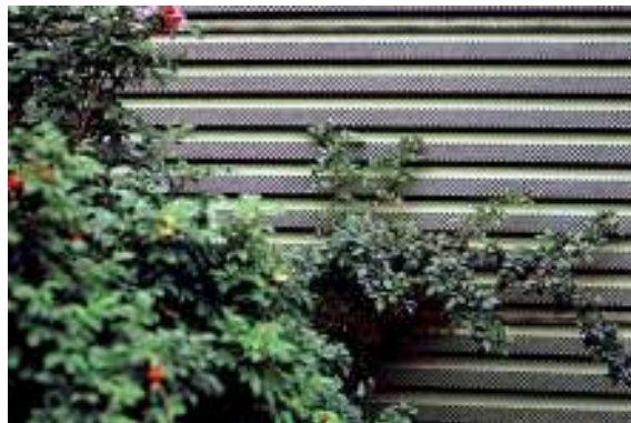
Figura 78 Barreira com painel absorvente em uma das faces, constituído por chapa metálica com perfurações de 6mm.
