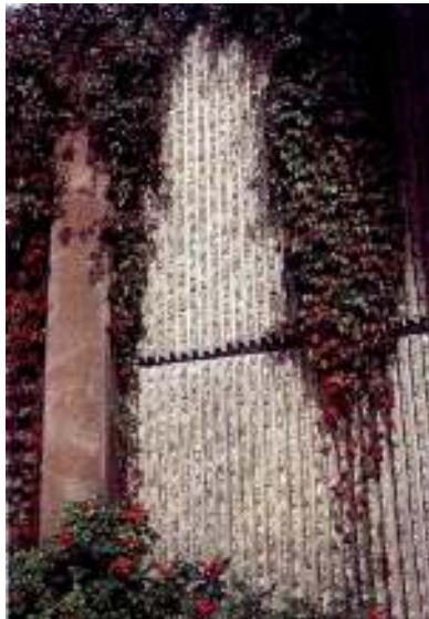
Figura 87 Barreira em concreto com face rugosa.
