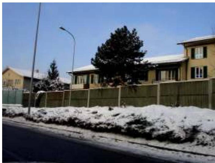
Figura 45 a) Barreira pública em Saint Moritz, na Suíça;
