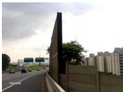
Figura 44 (a/b) Barreira acústica implantada na rodovia dos Bandeirantes para proteger um conjunto habitacional do ruído veicular.
