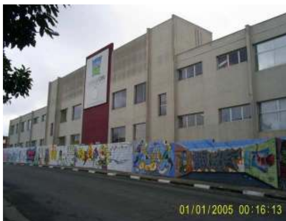
Foto: 1 - Fachada do Prédio
